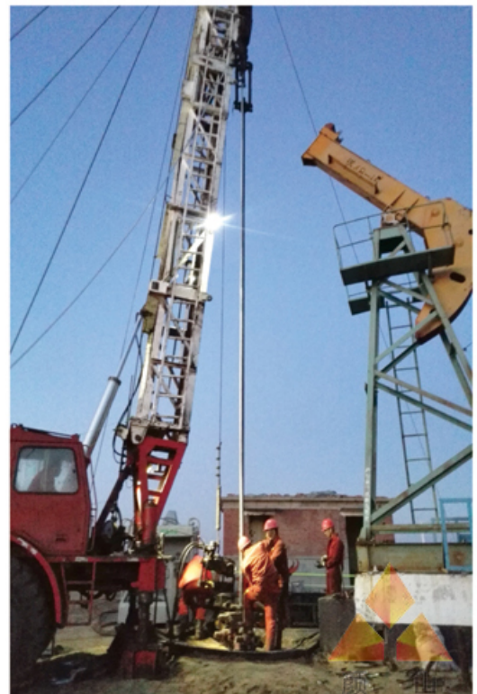
产品现场安装
